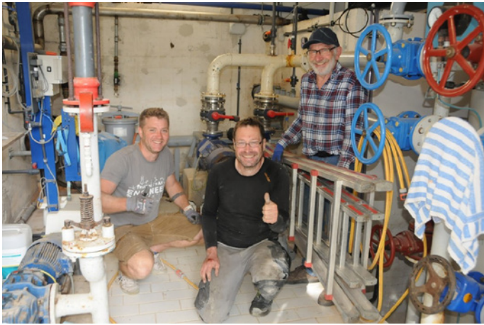
Im Pumpraum ein starkes Team: Sebastian Stehle, Manfred Burzler und Peter Griebel
