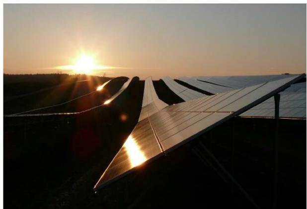
Bei steileren Winkeln über 2° kann es nur noch zu Teilreflexionen kommen, die mit zunehmend steileren Winkeln rasch abnehmen. Zugleich wird in dieser Phase das Sonnenlicht aufgrund der Neigung der Module, mit 10 bis 25° und deren Ausrichtung nach Süden bereits zunehmend nach oben in den erdfernen Bereich reflektiert.
