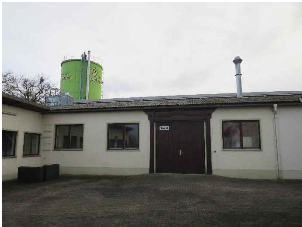
Bild 3: Bestand Halle 1 mit Lackierabsaugung
